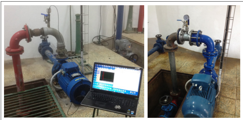
Figura 5. Auditoria à bomba velha (esquerda) e bomba nova (direita).
