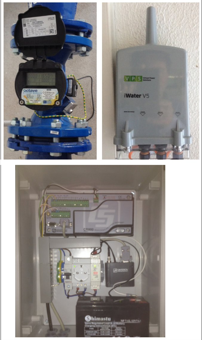
Figura 1. Exemplos de um caudalímetro (em cima, esquerda) e equipamentos de telemetria (em cima, direita e em baixo).
