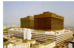
die größten Küchen: (10.000 Mahlzeiten pro Tag) Spitalküche des AKH Wien Betriebsküche der VÖEST Alpine
