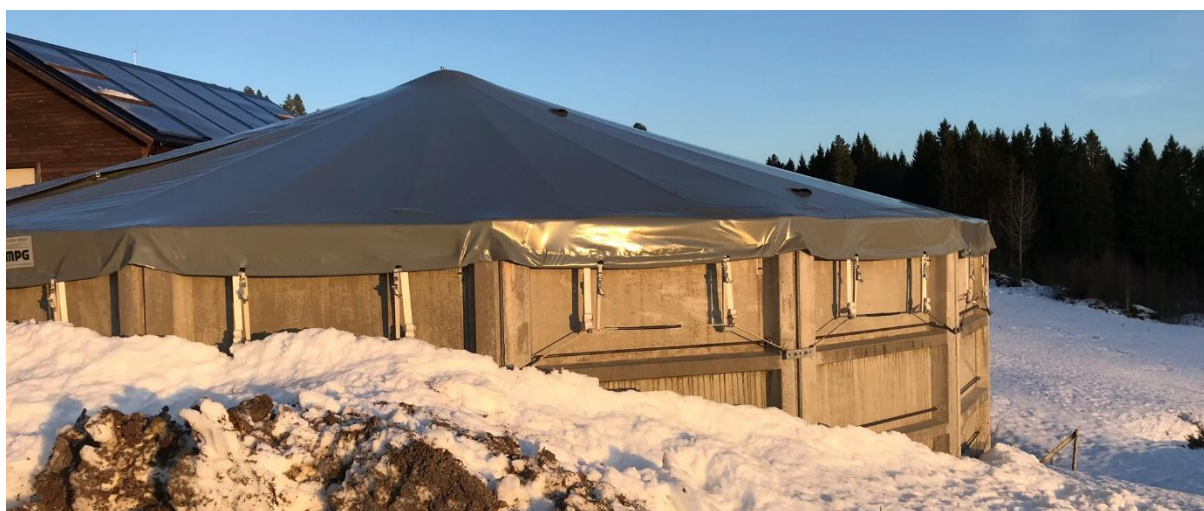
Bilde 13. Lager for biorest på Tingvoll gard. Kummen er delvis nedgravd og er på 620 m 3 . Foto: Sissel Hansen
