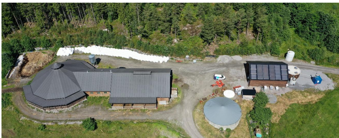
Bilde 11. Oversikt over fjøs, gjødselkum og biogass-anlegg på Tingvoll gard. Helt til venstre i bildet avdeling for melkekyr. Til høyre er biogassanlegget. Gjødsel fra ei flyterenne under dyra pumpes til biogassanlegget. Foto: Marius Bless
