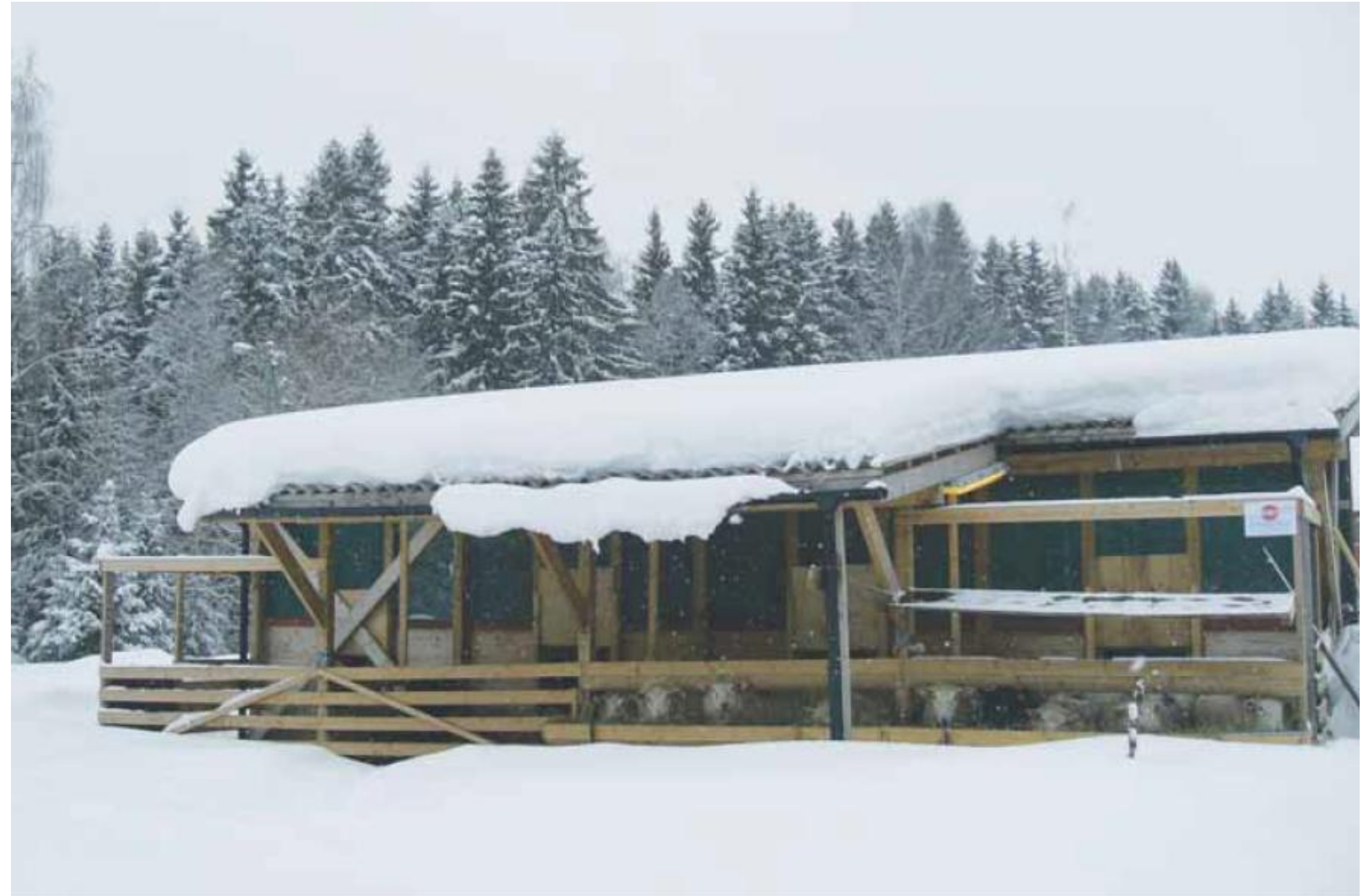
Fjøsset som ble brukt i forsøket. De fire bingene hadde enten fôr inne/uten tak; fôr inne/med tak; fôr ute/med tak; fôr ute/uten tak.)
