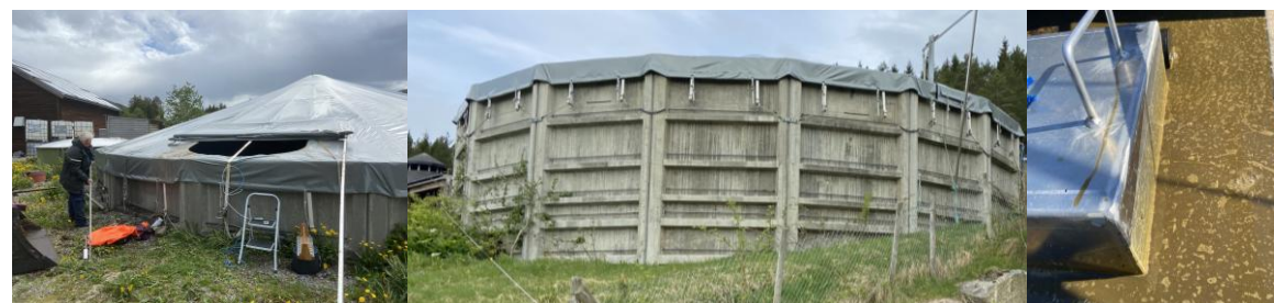
Bilde 6. Lageret for biorest på Tingvoll gard er også en kum med tak (KTtopp_biorest). Bioresten er svært tynn og lettflytende. Foto: NORSØK
