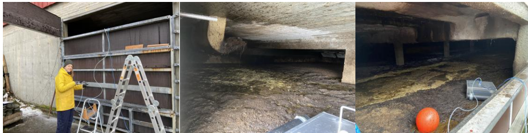
Bilde 3. Gjødselkjellere. De to bildene til venstre er fra lagre med tett forbindelse mellom fjøs og kjeller (FT) og bildet til høyre åpen forbindelse (FÅ). Vi tok uansett gassprøver gjennom gjødselporten. Foto: NORSØK.
