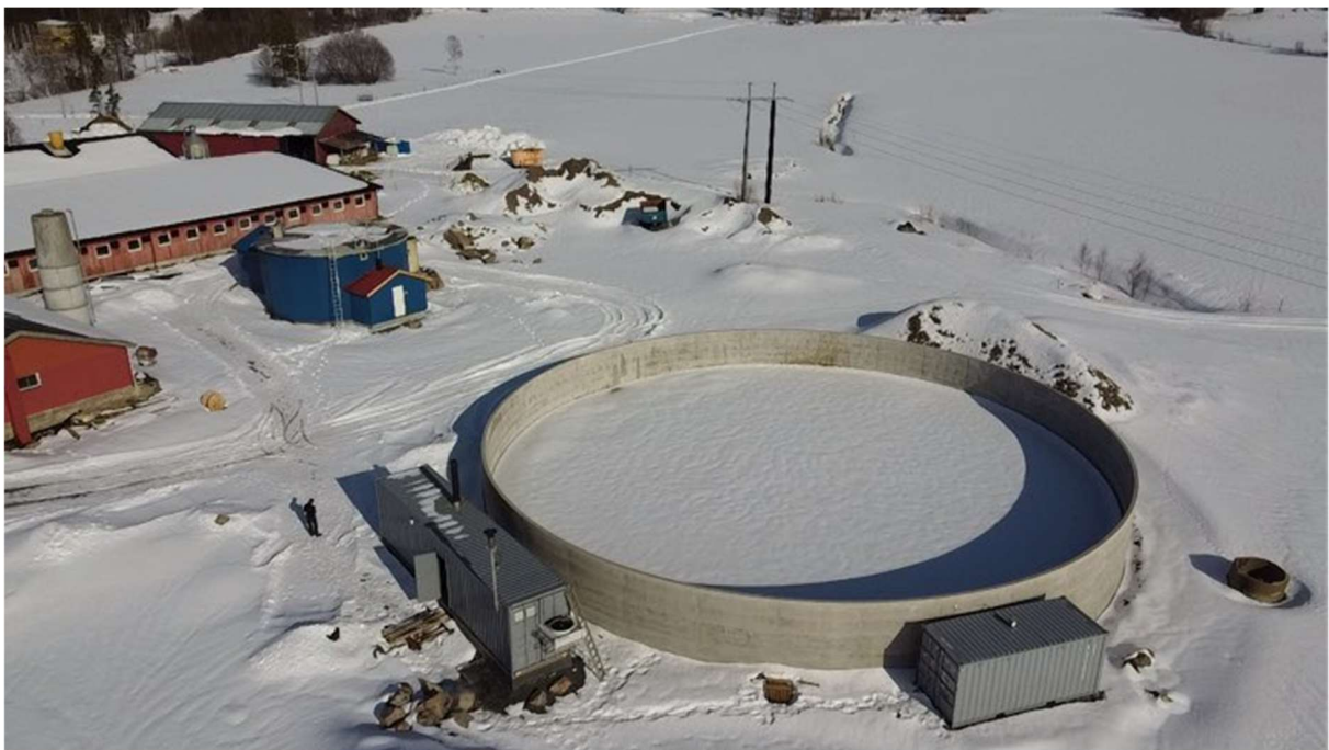
Bilde 5. Biogassanlegget. Reaktor oppe ved fjøset, teknikkonteiner med gassmotor til venstre for gjødsellager og gasslager nedenfor gjødsellager.
