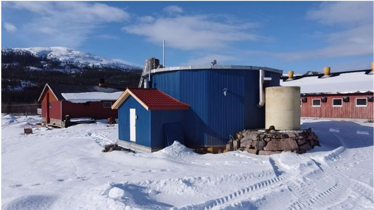
Bilde 3. Biogasreaktoren med teknikkhus til venstre og avkjølingskum til høyre
