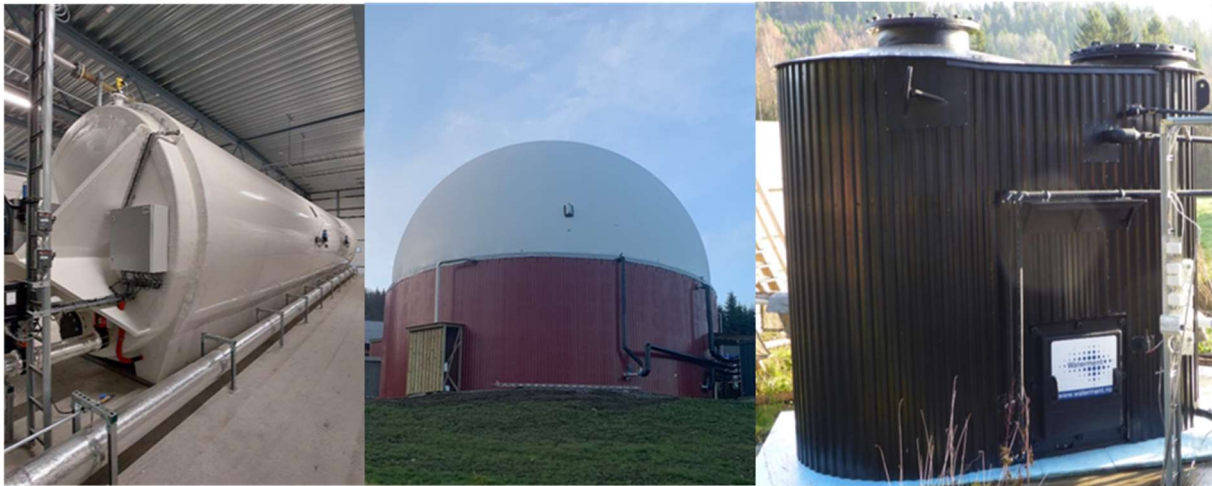
Figur 3. Ulike typer reaktorer, fra venstre PFR, Antec (105 m 3 ), CSTR, Nordisk Biogass (1150 m 3 ) og ABR, Waterment (10 m 3 ). Foto: Ingvar Kvande (PFR, CSTR) Øyvind Halvorsen (ABR).
