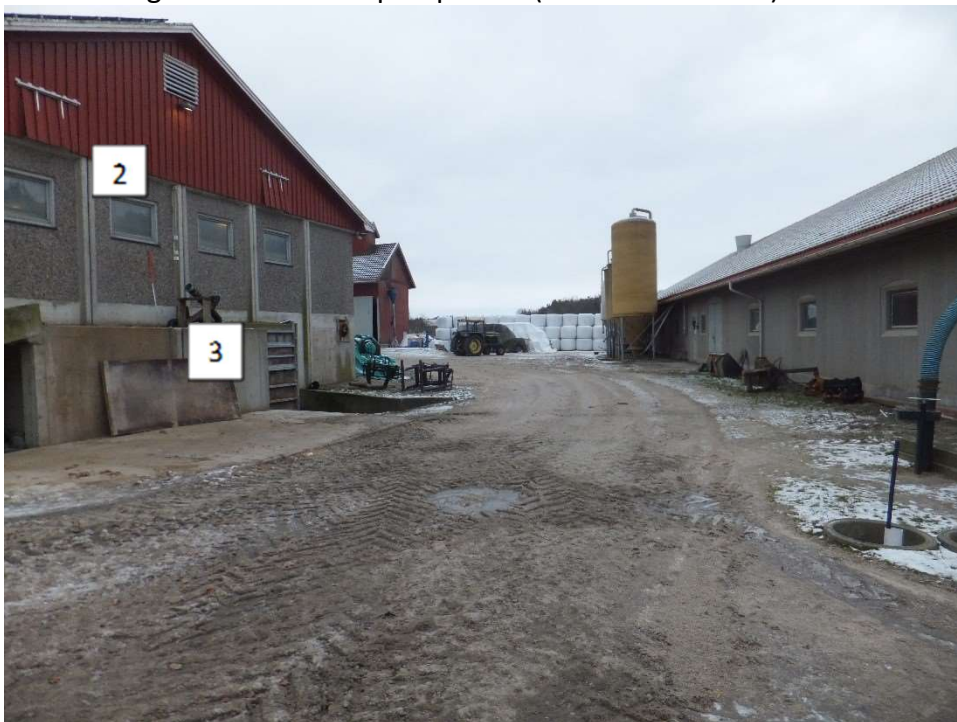
Bilde av 2- grisehus 1 med 3-pumpekum (til venstre i bildet)
