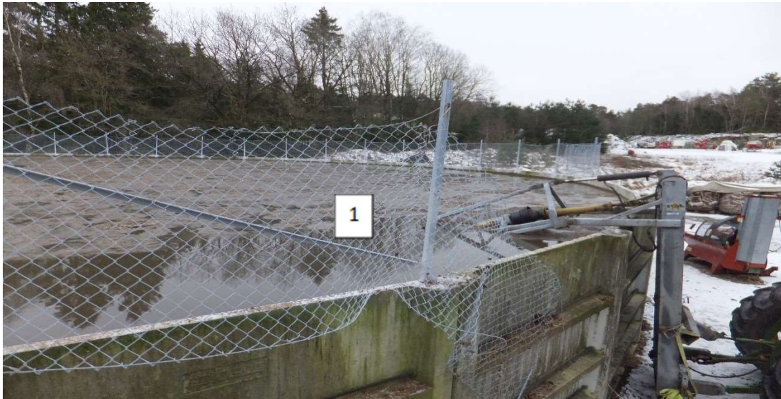
Bilde av 2- grisehus 1 med 3-pumpekum (til venstre i bildet)
