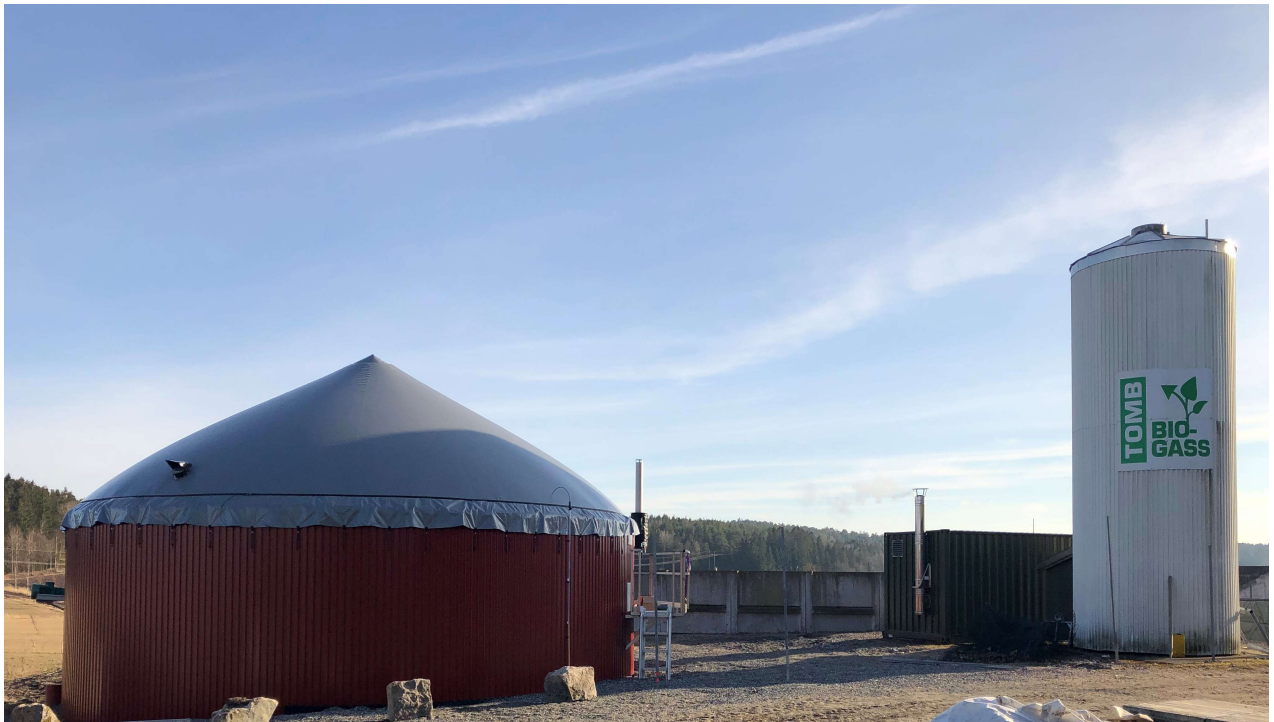
Biogassanlegg på Tomb videregående skole. Foto: Øyvind Halvorsen
