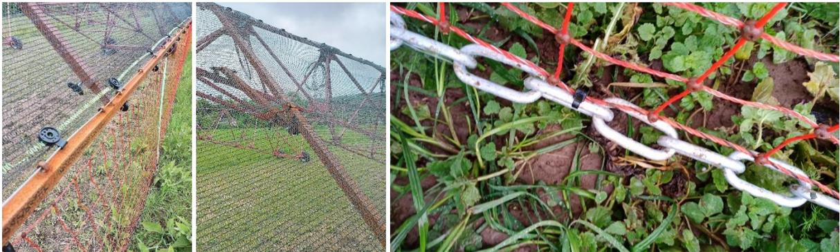
Abbildung 12: Auslaufvariante 1b – Links und Mitte: Höhenverstellung des Zauns; rechts unterer Zaunabschluss mit Kette
