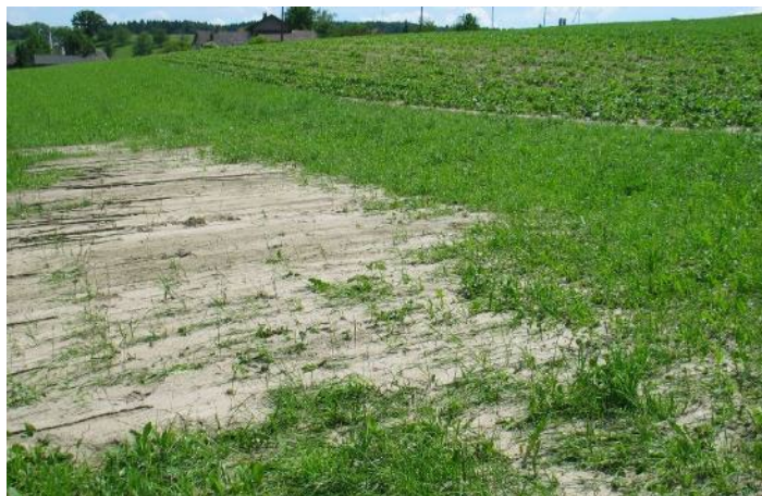
Protection contre l'érosion des sols
