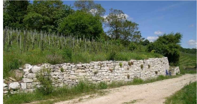
Murs de pierres sèches
