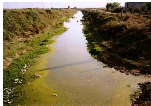
Bild 12: Hauptkanal für die Bewässerung (Foto: Christian, 2003)
