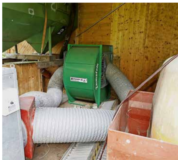
Il convient de contrôler son installation de séchage en grange avant d'attaquer la saison, en vérifiant les capacités des ventilateurs, les positions des claies, mais également l'emplacement des chaudières à mazout.
