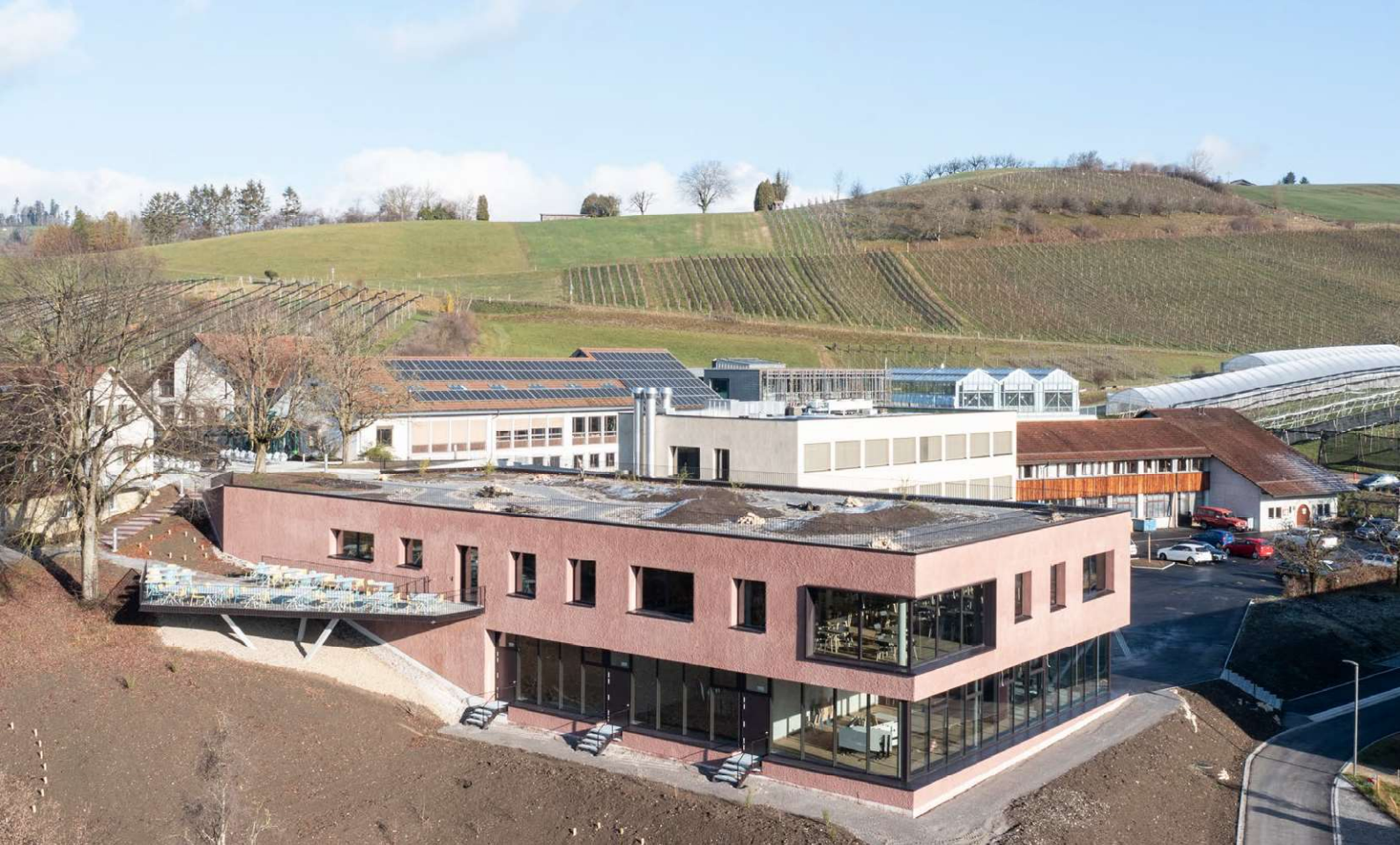
Le nouveau centre de séminaires a été construit avec le plus possible de matériaux provenant des environs de Frick, ce qui doit susciter l'impression que le bâtiment surgit organiquement du sol. Photos: Till Forrer
