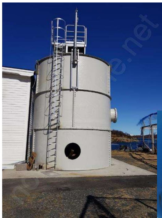
Industriskala hydrolysetank NB: pH < 4 !
