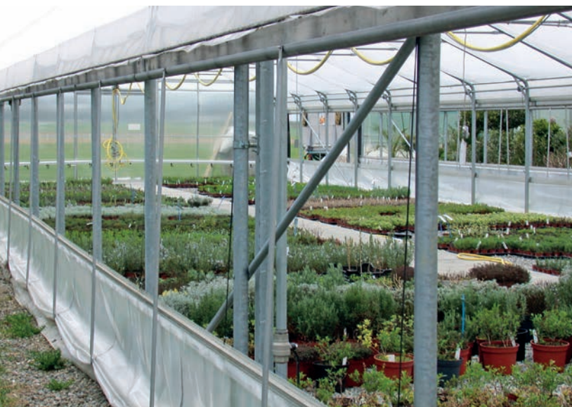
Verstellbare Seitenwände gewährleisten eine gute Durchlüftung des Gewächshauses und reduzieren damit das Risiko einer Infektion durch Krankheiten.
