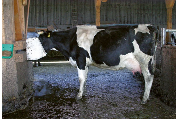
Lorsqu'un couloir comporte des installations telles qu'un abreuvoir, il doit être conçu subséquemment plus grand. Dans cet exemple, l'abreuvoir pourrait également être tourné de 90 degrés. Ainsi, un animal pourrait boire sans bloquer le passage.
