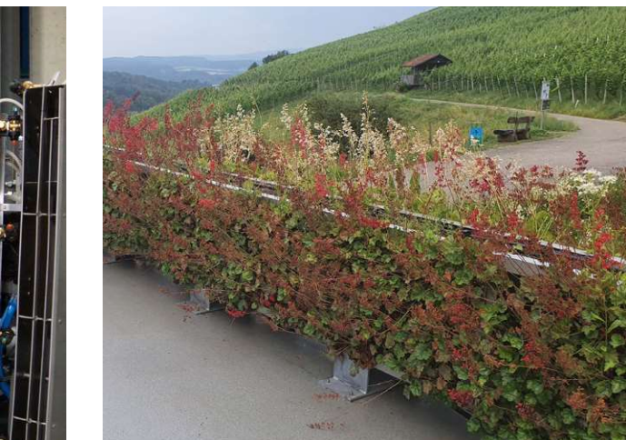
L'acqua di lavaggio viene convogliata verso una parete vegetale.
