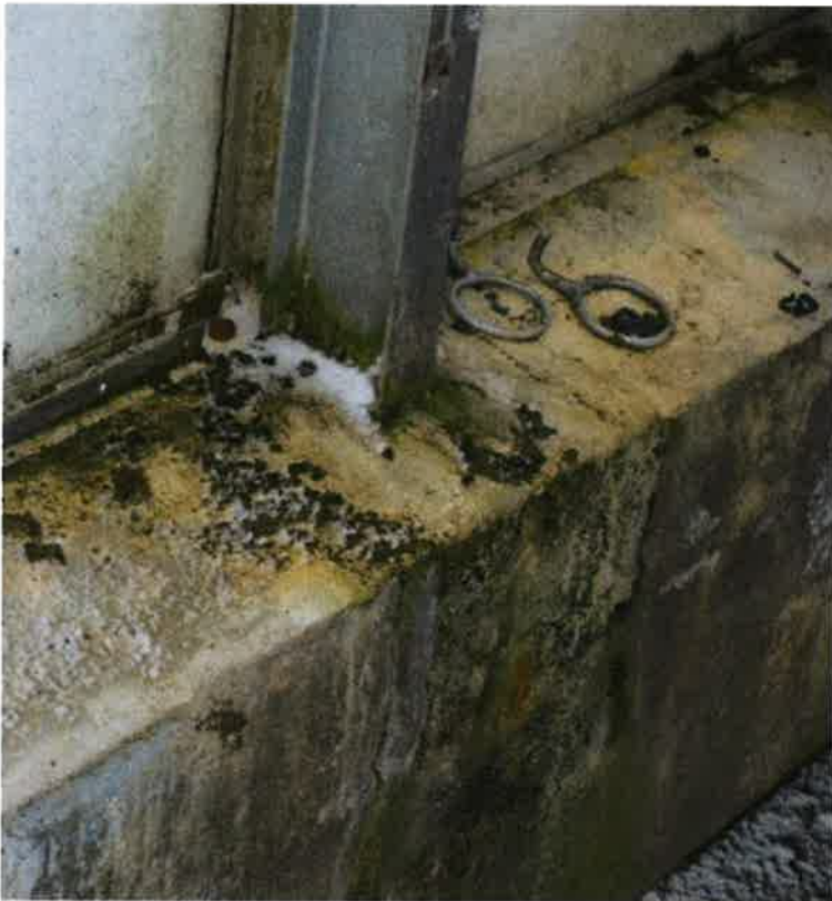
Ringmur (Bilete til venstre) eller sandwich-plater (Bilete til høgre) mellom sole og glasfelt er begge brukt i norske veksthus. Foto: Susanne Friis Pedersen
