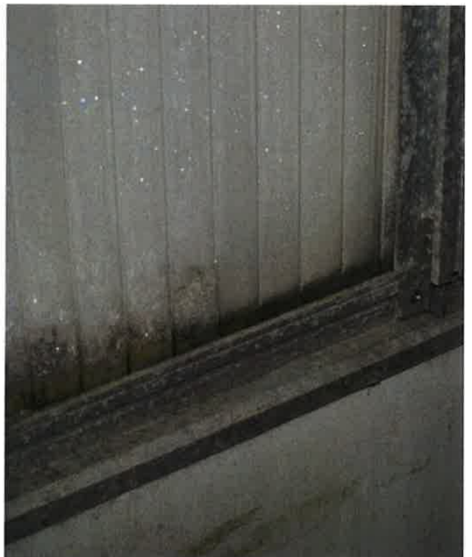
Ringmur (Bilete til venstre) eller sandwich-plater (Bilete til høgre) mellom sole og glasfelt er begge brukt i norske veksthus. Foto: Susanne Friis Pedersen
