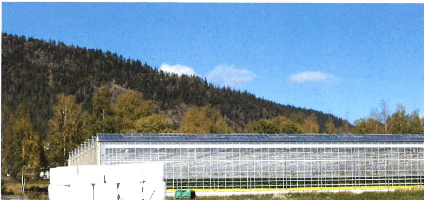
Takkonstruksjon med langsgående gitterbjelkar og fleire toppar etter kvarandre. Foto: Susanne Friis Pedersen
