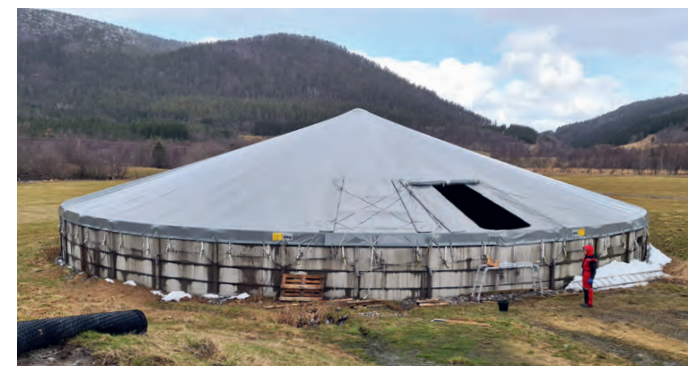
Tak over gjødsla hindrer nedbor i kummen samtidig som ammoniakk-tapet blir mindre. Foto: P. Haugnes, NORSØK.
