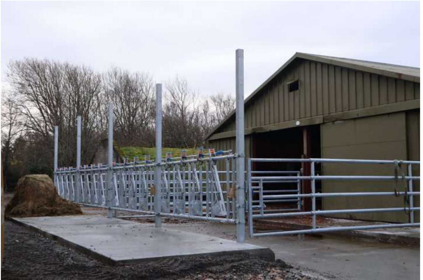
GAMLE BYGNINGER FÅR NYTT LIV: Fanghekk og føringsplass letter arbeidet med håndtering av store dyr. Foto: Rose Bergslid
