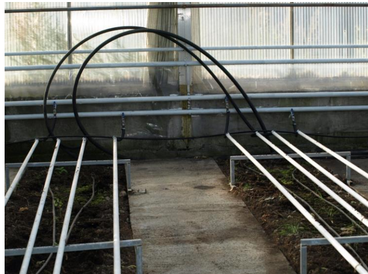
Bilde 8. Varmerør kan konstrueres for på- og avkobling etter behov. Foto: Susanne Friis Pedersen
