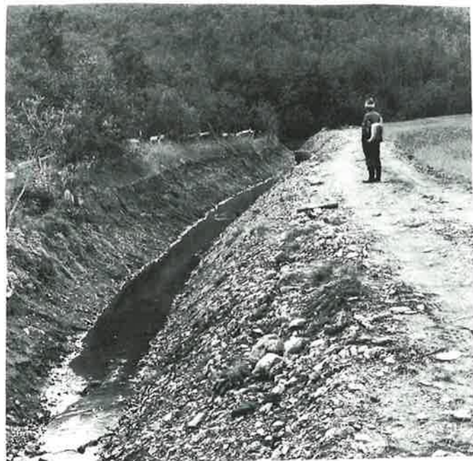
En dyp åpen grøft er gravd for å senke grunnvannstanden. Her ses også deler av fast kjørevei og utmark. Foto: H. Vittersø, aug. 1995
