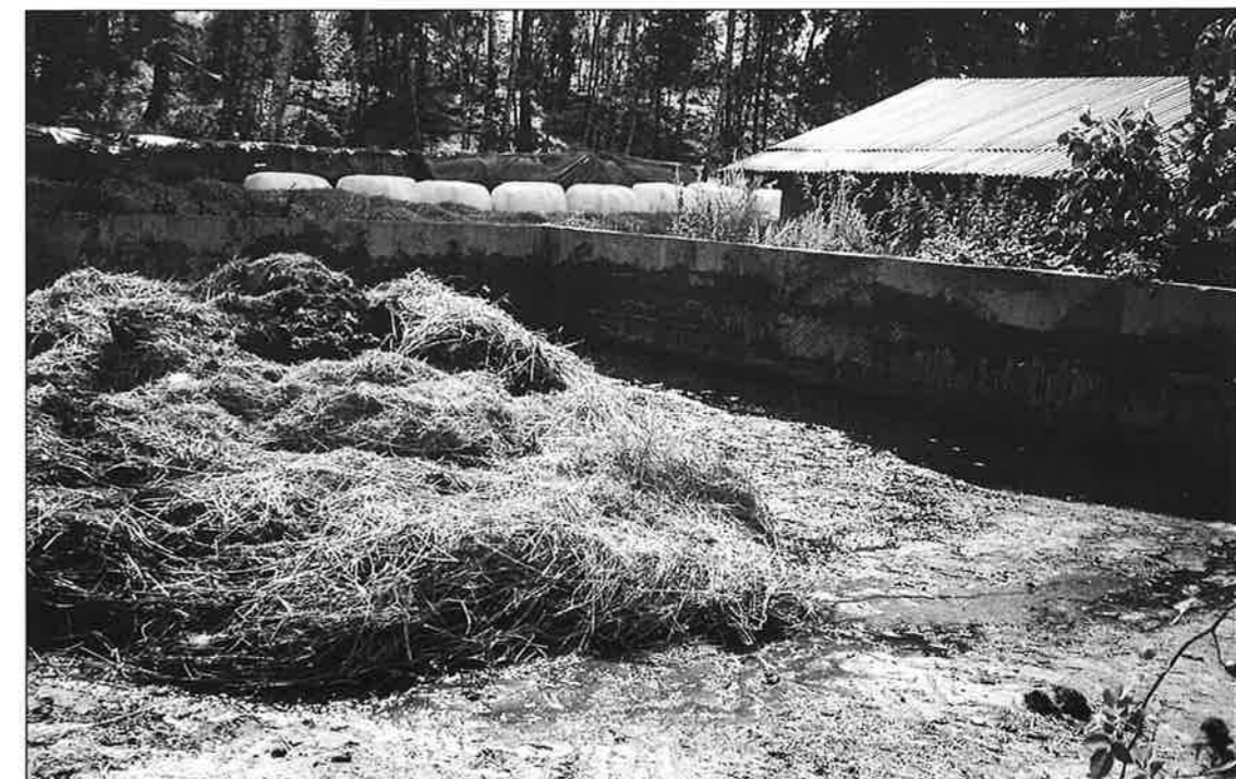
Gjødselplattingen av betong har avrenning til lannkummen, som er overbygd med tak (bak til høyre).
