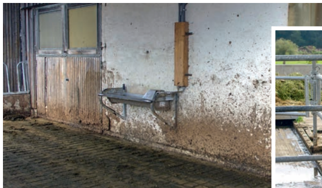
Tränken im Laufhof müssen frostsicher sein.
