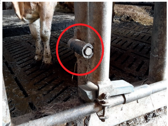
Puffergummis, die nicht schnell verschleifen, zur Minderung der Lautstärke.
