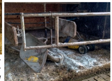
Defekte oder nicht nutzbare Liegeboxen sollten zeitnah repariert werden und dürfen bei der Berechnung der verfügbaren Liegeboxen pro Tier nicht mitberücksichtigt werden.
