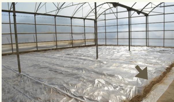
Fig. 3: Después de poner la cubierta plástica, se deben sellar los bordes con tierra u otro material, para evitar pérdidas de aire caliente.
