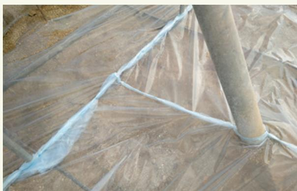
Fig. 4: El sellado del plástico se puede realizar mediante el grapado.
