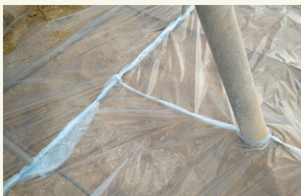
Billede 4: Forsegling af film kan laves med hæfteklammer.
