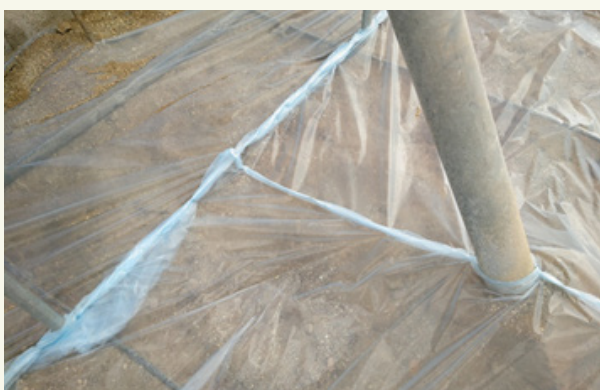
Obr. 4: Utěsnění překryvů může být provedeno sešíváním.
