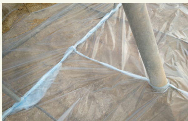
Fig. 4: A vedação na junção dos filmes pode ser realizada com grampos.
