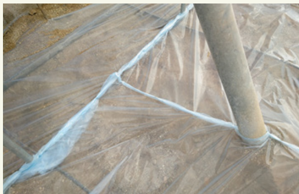
Obraz 4. Połączenie warstw folii przez zszywanie
