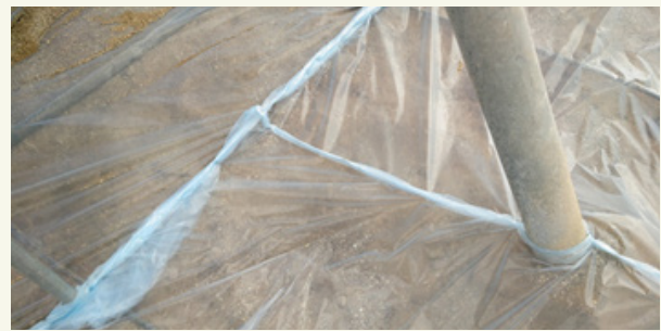
Fig. 4: Het afdichten van het afdek materiaal kan door middel van nieten worden gedaan.
