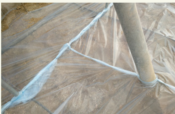
4 pav.: Skirtingi plėvelių sluoksniai tarpusavyje gali būti sujungti kabėmis.
