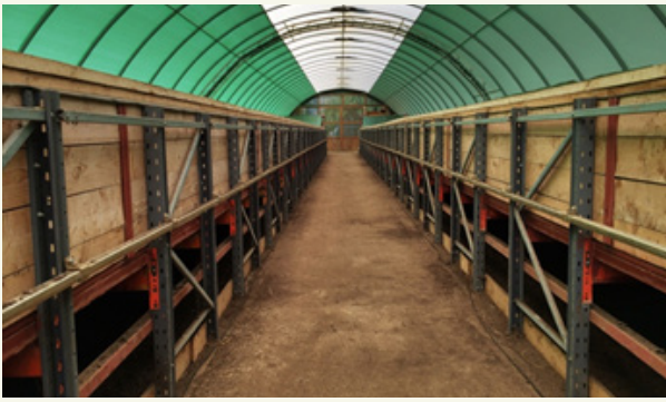
Fig. 2: Installation de vermicompostage à l'intérieur en flux continu, Autriche.
