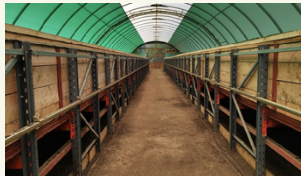
Imagem 2: Fluxo contínuo, instalação interna de vermicompostagem, Áustria.
