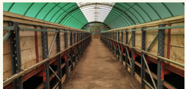
Fig. 2: Flusso continuo, impianto vermicomposting coperta, Austria.
