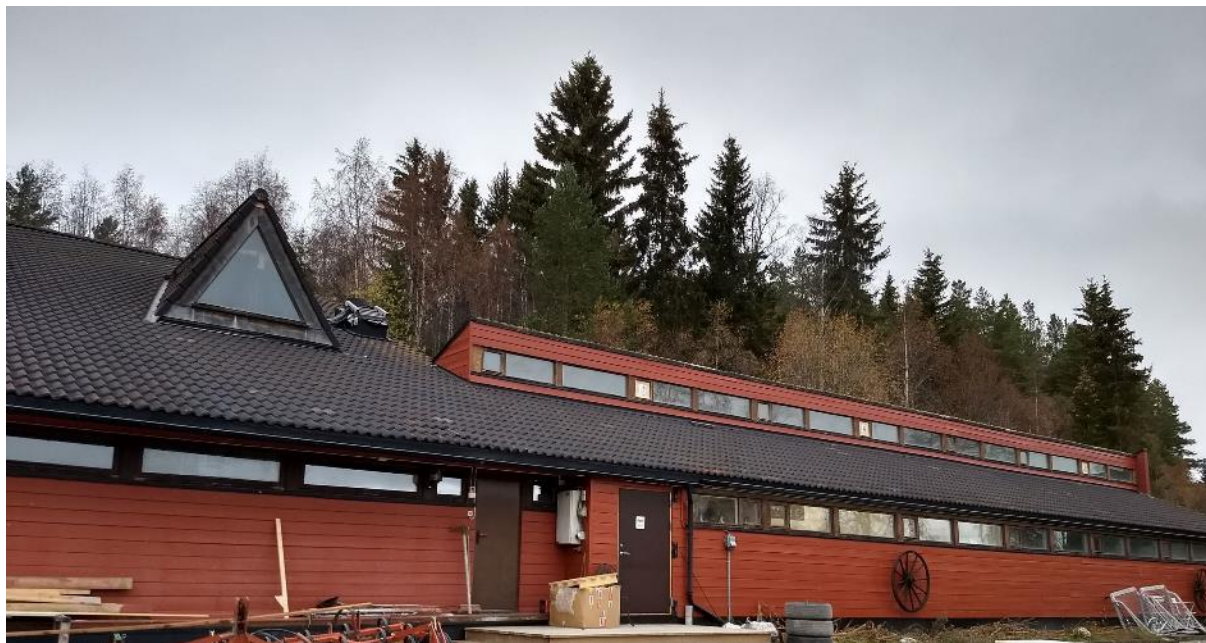
Et eldre kuffjøs er bygd om og innredet til produksjonslinje for bygg på Gardseth, 500 moh., på Tynset. Foto: Liv Solemdal
