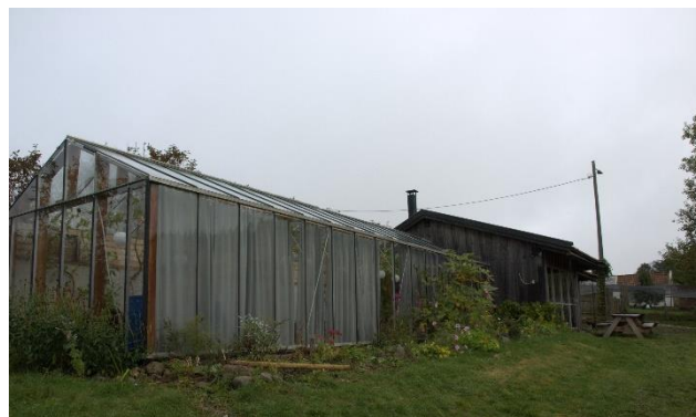
Bilde 2: Forreste drivhusbygg har varmvegg av mur der det vokset druer oppad. Bakerste drivhusbygg har steinmur som også lagrer varme. Foto: Susanne Friis Pedersen.
