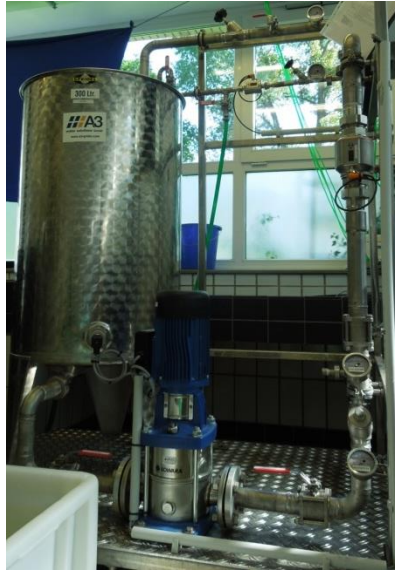
Abbildung 3: Ultrafiltrationsanlage, die in den Filtrationsversuchen verwendet wurde.
