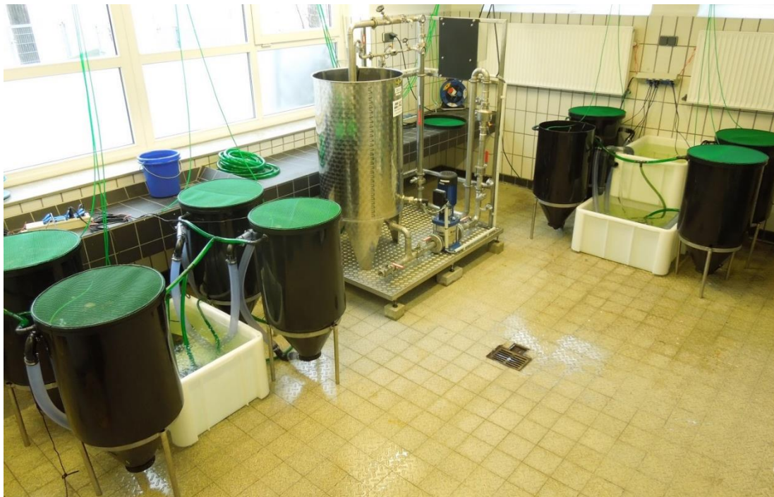
Abbildung 4: Aufbau der beiden Kreisläufe mit jeweils vier Rundstrombecken sowie der Ultrafiltrationsanlage für die Filtrationsversuche.
