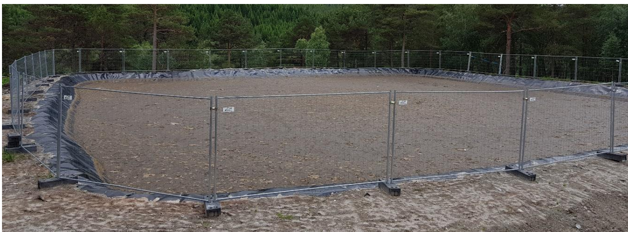
Bilde 21. Gjødselkum (lagune) uten tak. Dersom det kommer 1500 mm nedbør gjennom året vil dette gjødsellageret samle opp 1 700 m 3 med regnvann. Foto: Rose Bergslid, NORSØK.
