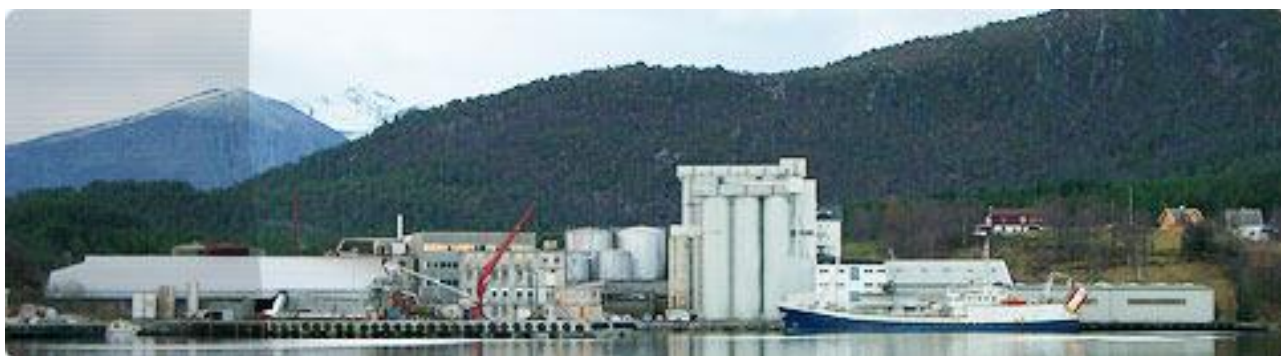
Bilde 3. Vedde sildoljefabrikk i Langevåg, Sunnmøre. Foto: Vedde sildoljefabrikk, www.vedde.no
