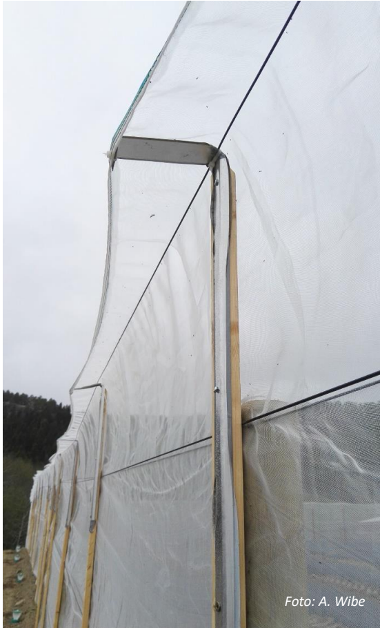
Bilde 3. Detaljer fra toppen av gjerdet. Ved hjelp av aluminiumprofil ble det dannet en fals som skal hindre jordbærsmuttbiller i å krysse over gjerdet. Nettet ble festet i toppen med strips. Syv lengder med Deltex wire er med å sikre nettet mot skader forårsaket vind.
