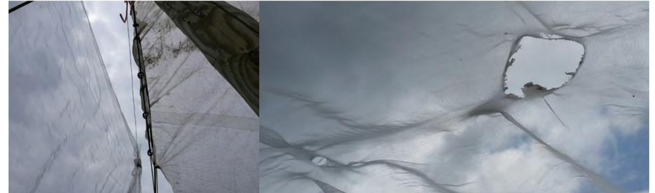
Fig. 27 et 28 : trous en le filet et le plafond en toile doivent être fermés ; les trous peuvent servir de portes d'entrée aux mouches Photos : Augel/LTZ
