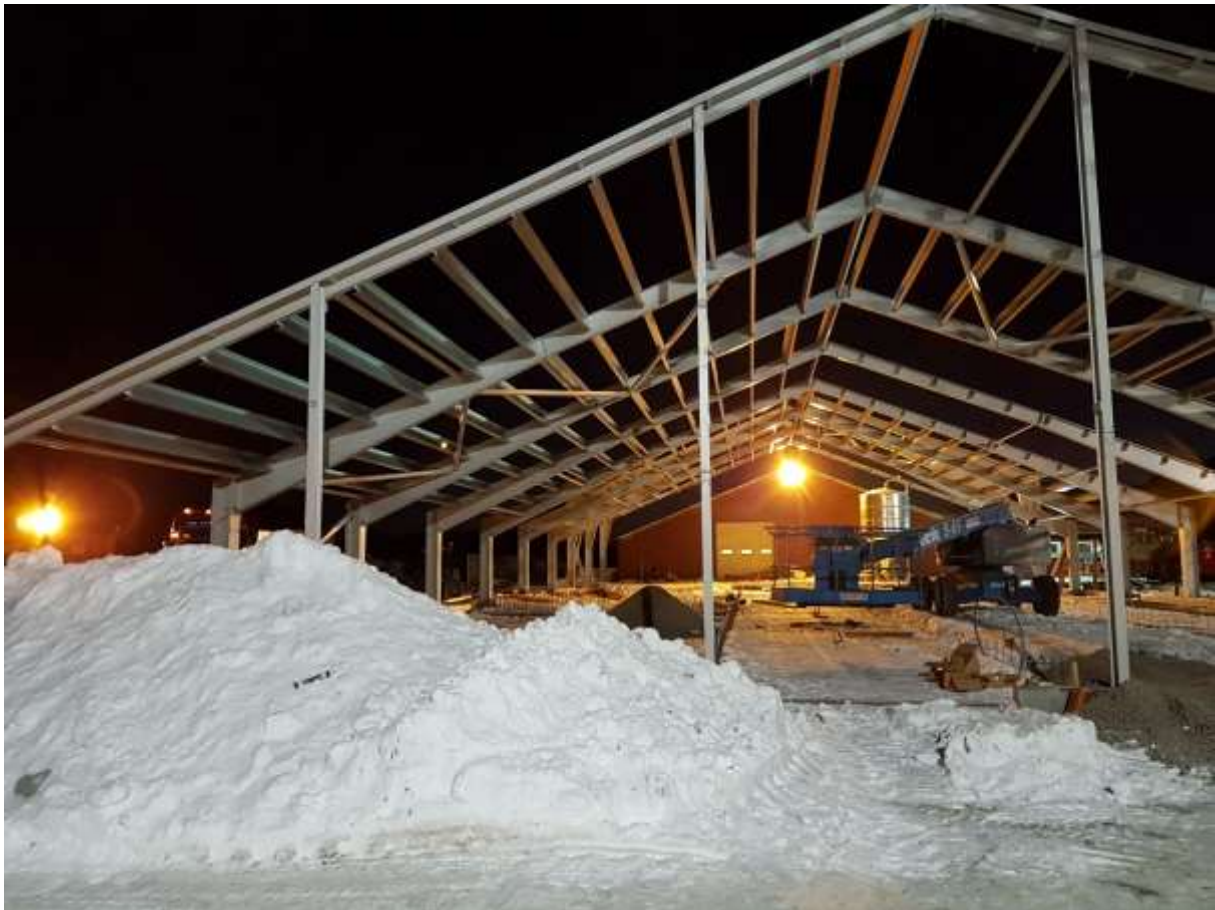
Bygging av store driftsbygninger samler mange dyr noe som kan gi utfordringer for beite-/mosjonskravet
