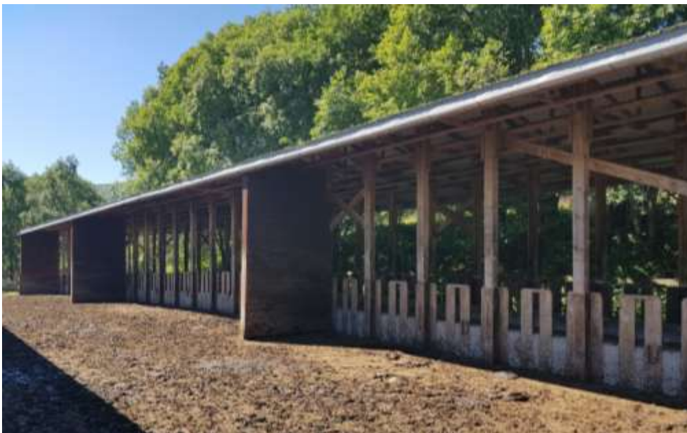
Fôringshus med plass til 100 melkekyr. Gjødsla skrapes med traktor ned i et gjødsellager
