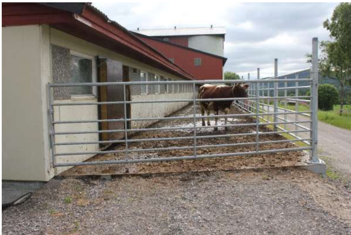
Luftegården er fylt med pukk under for å heve luftegården opp til dørnivå. Nærmeste dør ble laget i forbindelse med luftegårdbyggingen, og den er isolert. I front er det mulig å kjøre inn med traktor ved behov.
