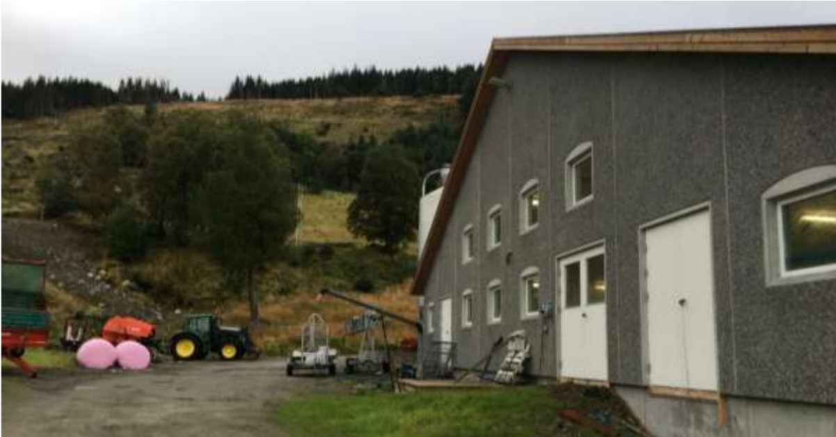
Bilde er tatt før luftegården ble etablert. Om sommeren åpnes dørene slik at dyra får fri tilgang til luftegården. Ovenfor driftsbygninga vises et rydda skogsfelt som er tatt i bruk av ungdyr
