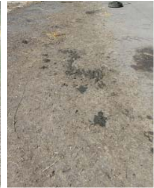
Foto 10: Beton bzw. Asphalt-Triebwege
