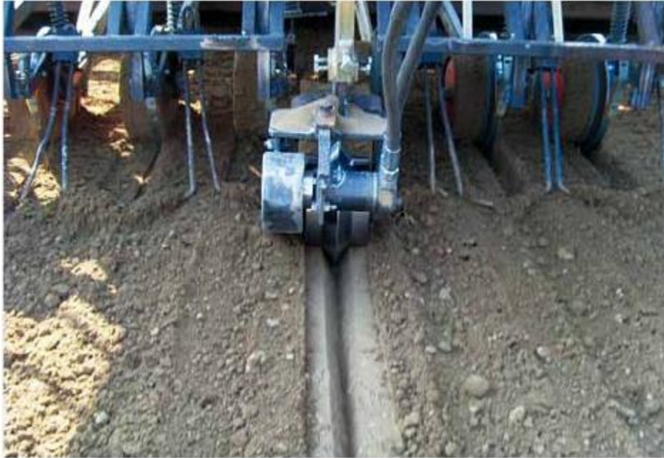
Joonis 3.4.5: Vihmakindla markeerimisjoone paigaldamine
