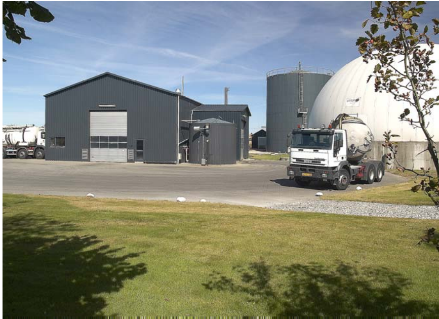
Figur 3.1 Billede af et biogafællesanlæg (foto Torben Skøtt)
