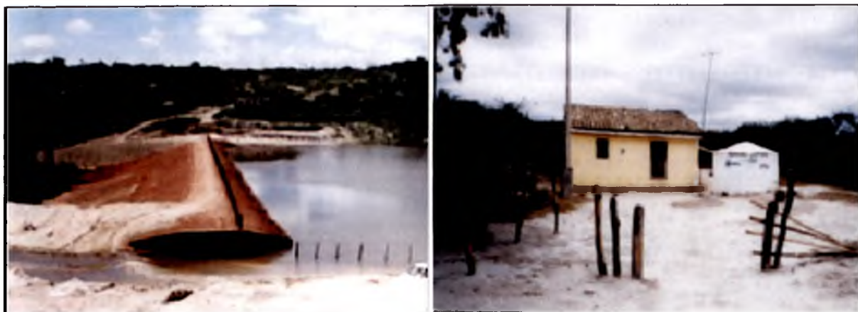
Foto: Infraestructuras construidas por el proyecto: Presa, cisterna.
