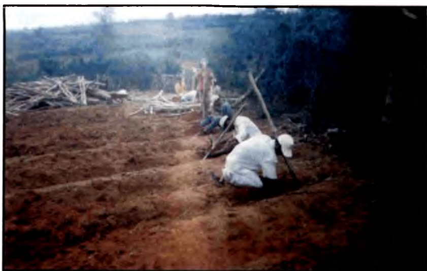
Foto: Construcción de cercas en trabajo de ayuda mutua
