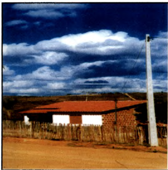
Foto: Conexión de energía eléctrica en el hogar.
