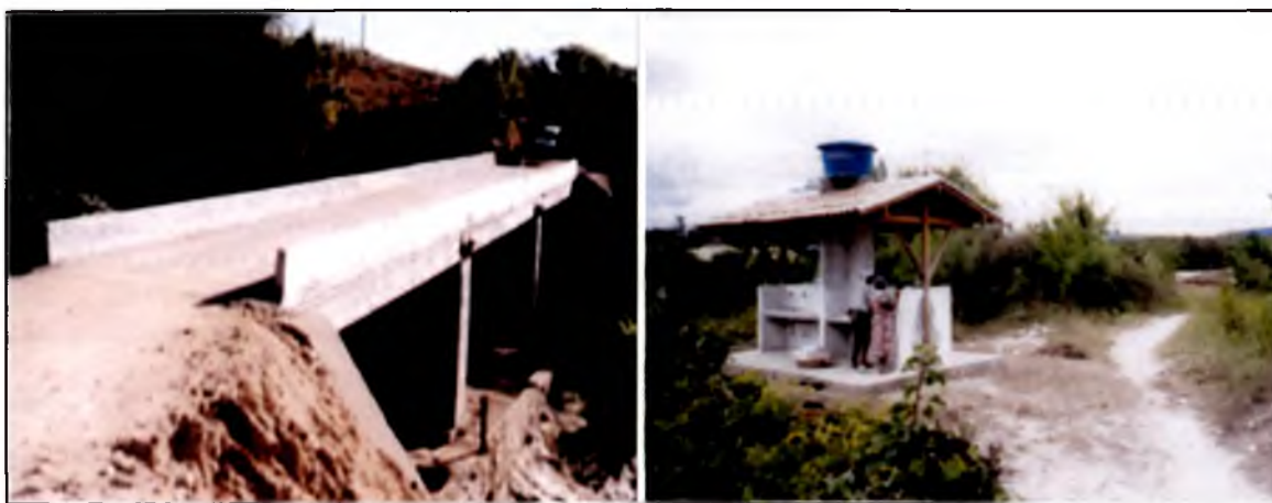
Foto: Infraestructuras construidas por el proyecto: Puente y lavanderia.
