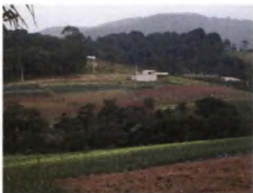
Vista parcial de uma unidade produtiva, observa-se terreno com declividade
