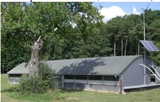
Abb. 1: Würdekemper Mobilstall für 1.000 Legehennen; die Energieversorgung erfolgt durch Wind und Sonne
