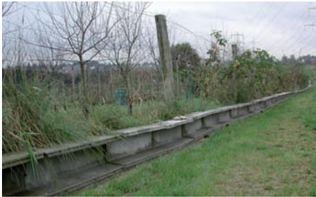
Barrierelösung aus Beton-U-Elementen auf einem 70 cm tiefen Betonfundament. Diese Variante ist im Vergleich zu Barrieren aus Drahtgitter sehr teuer.
