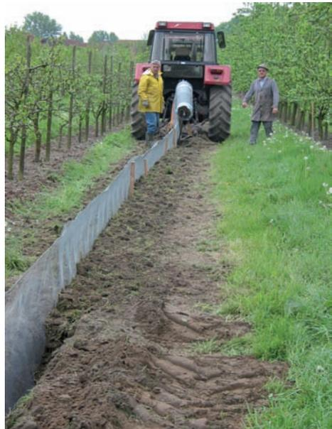
Ein einfaches Verlegegerät erleichtert die Installation des Barrieredrahtes in einen zuvor angelegten, 50 cm tiefen Graben.
