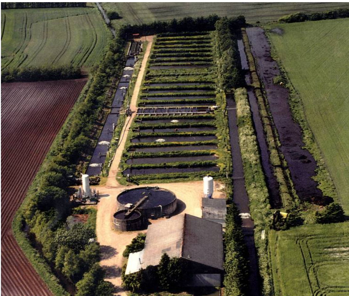
Figur 2.1 Et traditionelt dansk dambrug (Hestlund Dambrug) bestående af jorddamme. Vandet ledes fra åen (evt. fra opstemning) til en indløbskanal (højre side af billedet) ind til hver enkelt dam. Fra dammen passerer vandet gennem udløbsristen til bagkanalen (venstre side af billedet), hvorfra det efter rensning (i sidste del af bagkanalen) ledes tilbage til åen eller evt. genbruges ved returpumpning til indløbet. Foto: Kruse Lufffoto
