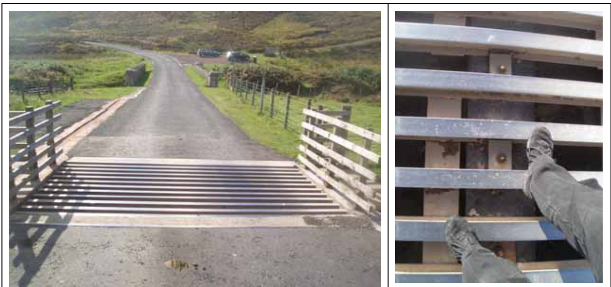
Abb. 38: Rost zur freien Überfahrt auf großen Schafweiden in Schottland
