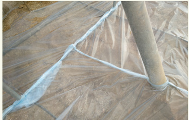
4. ábra: A fóliarétegek rögzítését tűzőkapcsokkal oldhatjuk meg.
